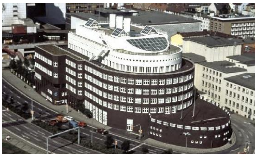
Рис. 7. Первое главное здание Института полярных и морских исследований им. Альфреда Вегенера, открытое в 1986 г. в Бремерхафене. В ходе расширения АВИ было построено или реконструировано несколько дополнительных зданий в различных местах. Архив АВИ
